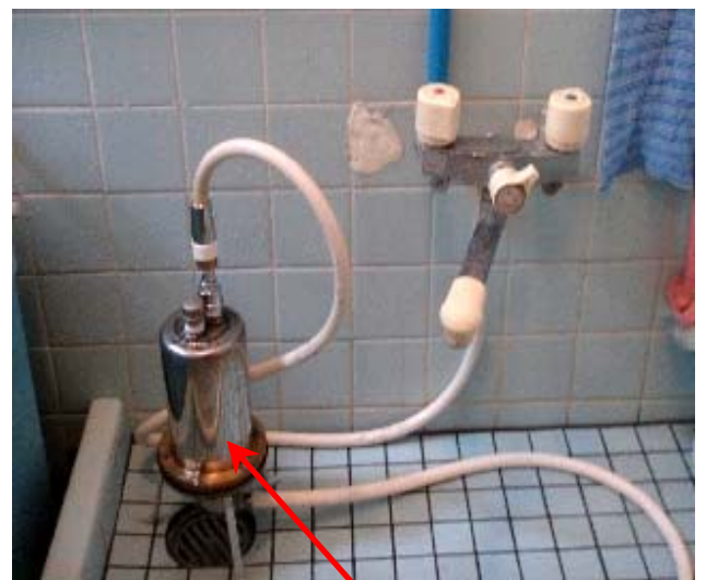
マイクロバブル発生用小型タンク 独自の特殊な加圧溶解型
